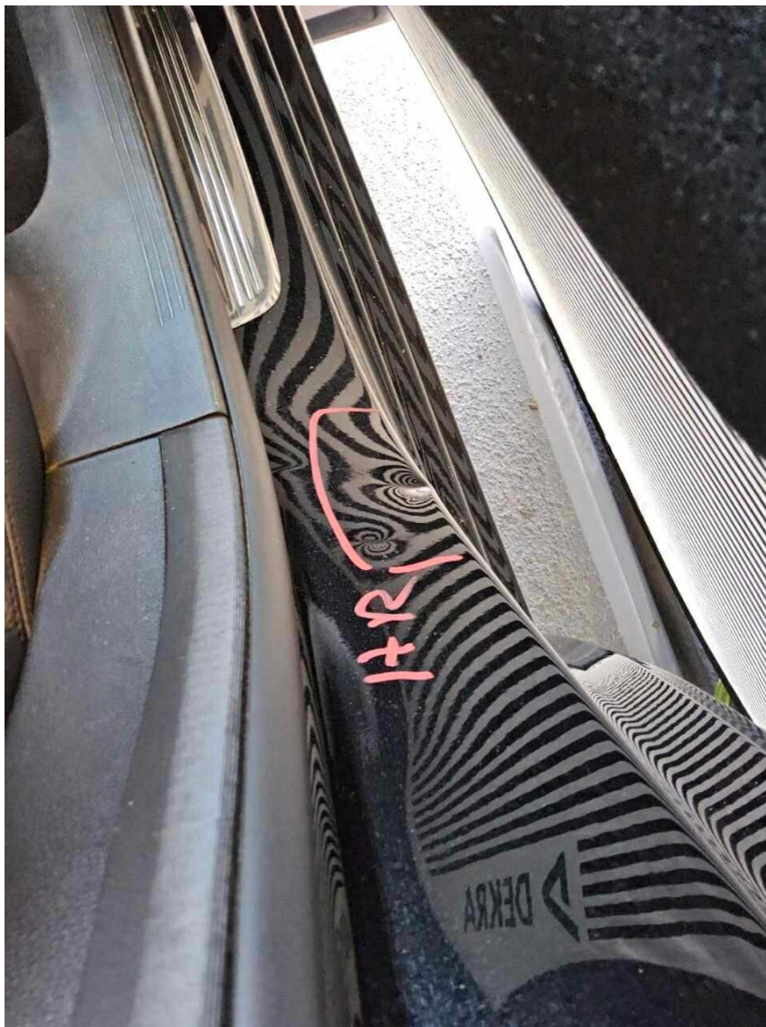
Bild 20 : Seitenschweller rechts, deformiert, instandsetzen und lackieren mit Lackaufbau
