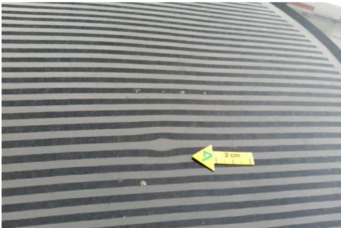
Bild 15 : Dach, eingedellt, drücken
