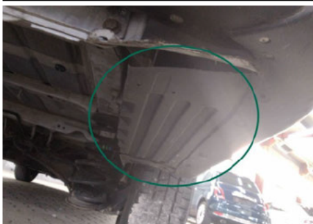
Abdeckung / Unten Hinten Rechts / Gebrochen
