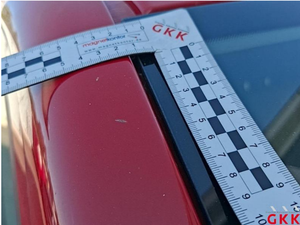
Bild 37. A- Säule rechts, beschädigt, instand setzen - lackieren
