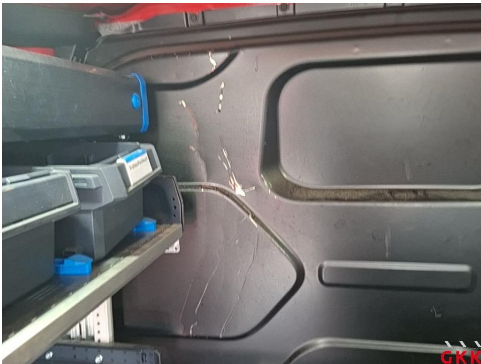
Bild 30. Trennwand, verkratzt, Smartrepair
