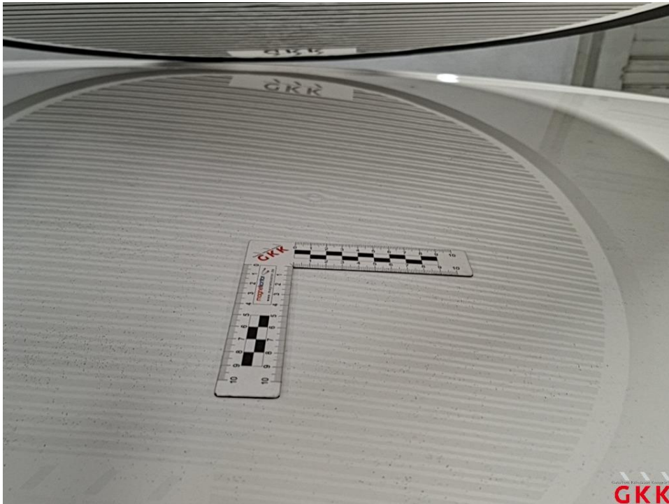
Bild 13 Dach, beschädigt, kalt drücken
