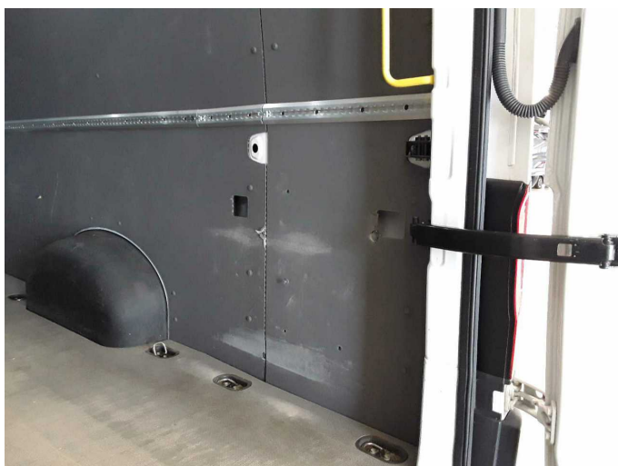
Damage 1: Interior: Interior (Laderaumverkleidungen) - Broken / torn - Replace
