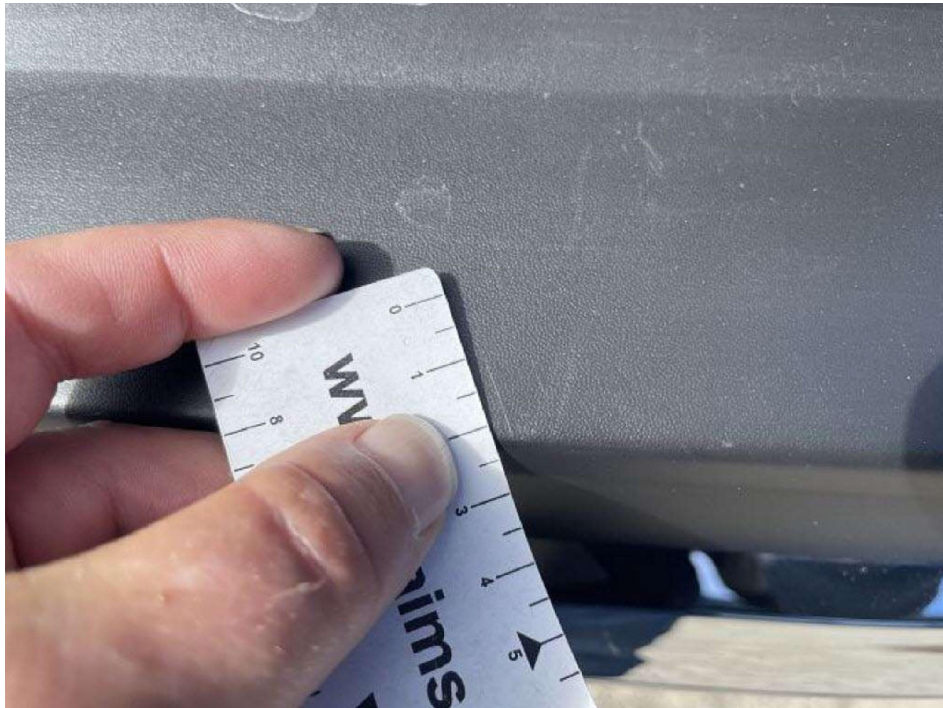
Bild 15 Stoßfänger Hinten Mitte - Verformt mit Materialabtrag
