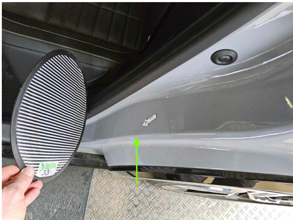
Bild 22 : Tür hinten links Einstieg, eingedellt, drücken
