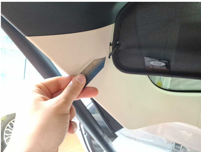
Damage 6: Trim / covers: Boot lid - interior trim (Sichtschutz mit Kabelbinder befestigt) - Malposition - Replace
