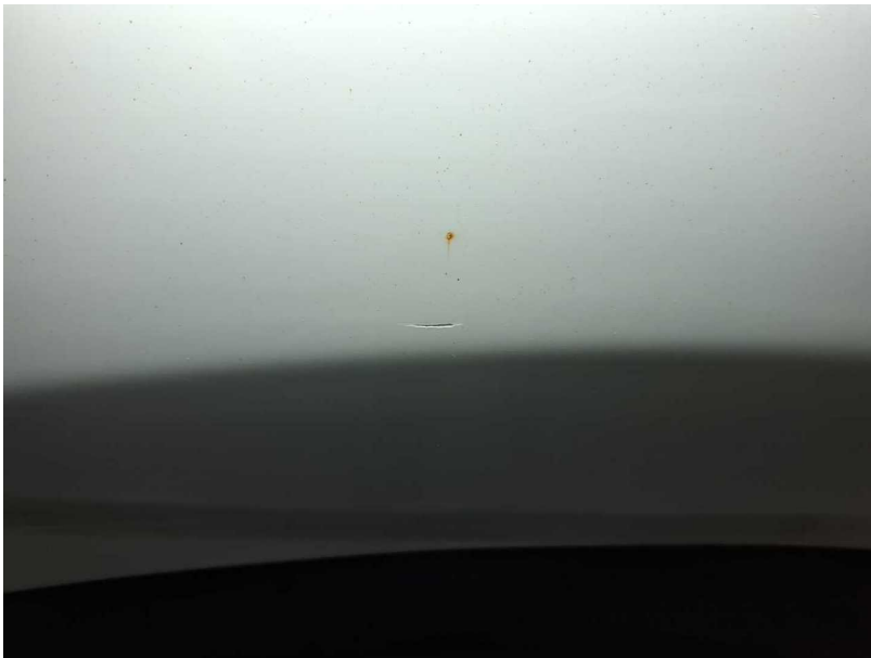
Beschädigung #32: Seitenwand links: Seitenwand (+ Beplankung HLU) - Kratzer - lackieren
