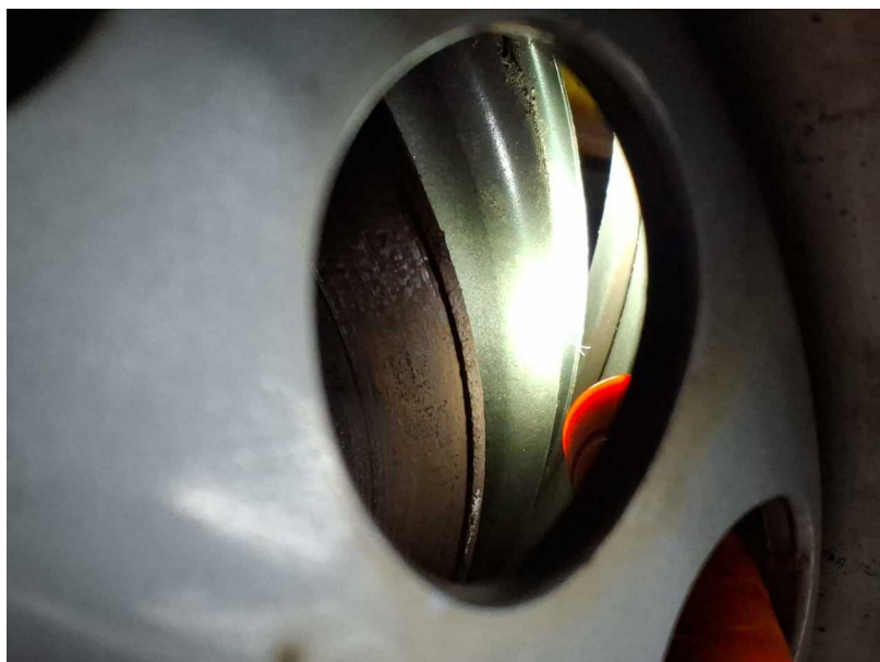
Beschädigung #26: Bremsanlage: Bremsscheiben und Beläge hinten (Inkl. Feststellbremse) - verschlissen - erneuern
