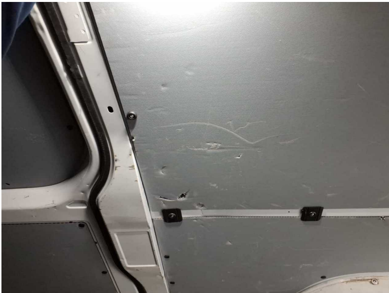
Beschädigung #35: Verkleidungen/Abdeckungen: Laderaum (10x) - gebrochen / gerissen - erneuern
