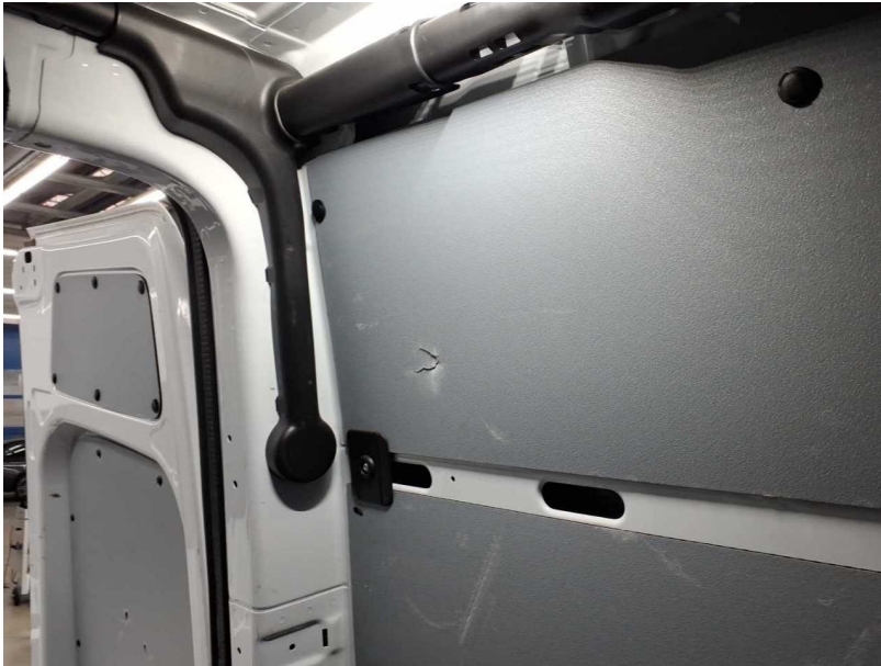
Beschädigung #35: Verkleidungen/Abdeckungen: Laderaum (10x) - gebrochen / gerissen - erneuern
