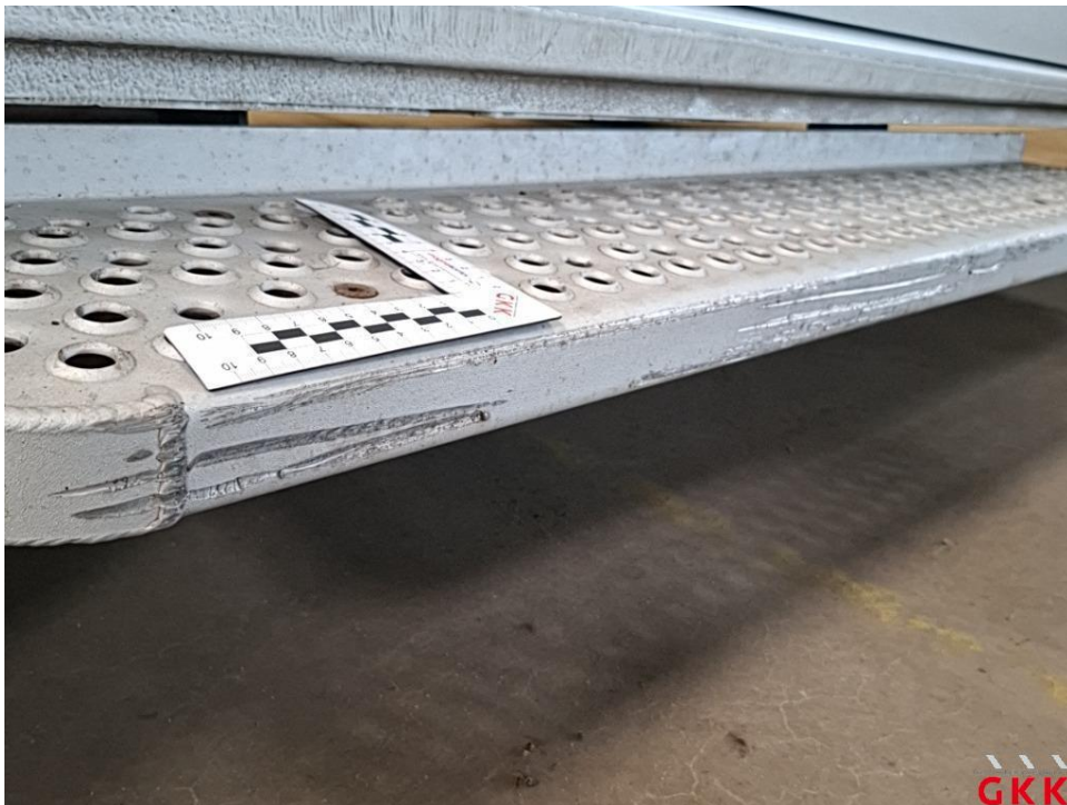
Bild 40 Trittbrett, verkratzt, ersetzen
