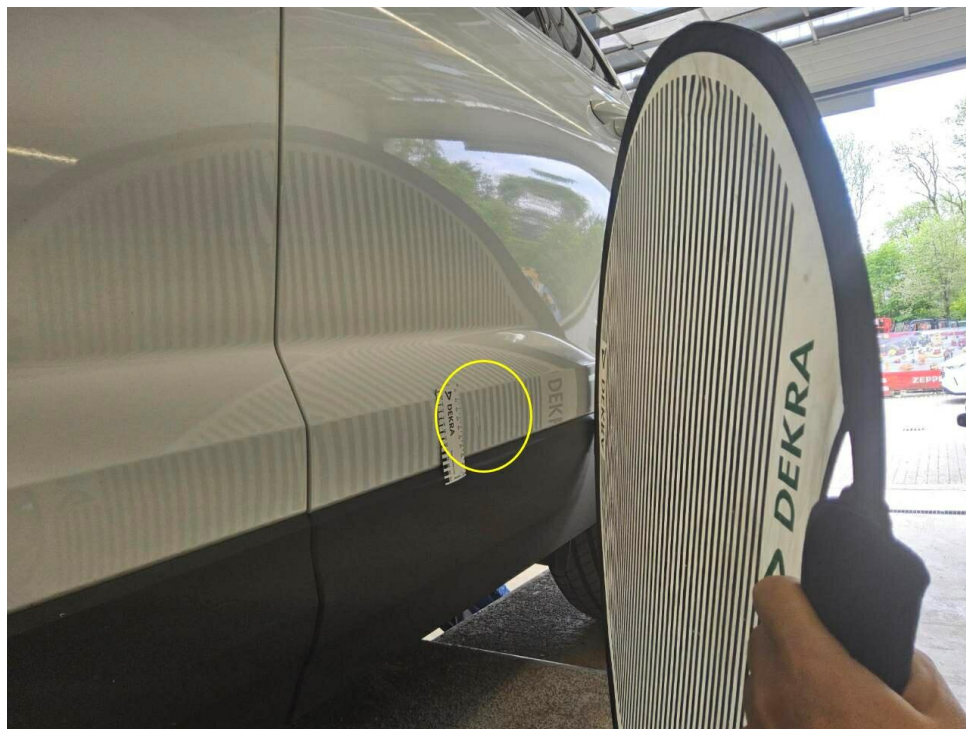
Bild 15 : Tür hinten links, eingedellt, drücken
