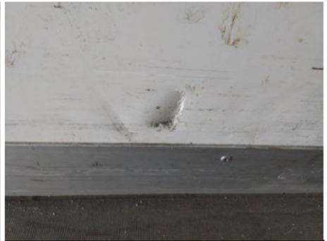
Seitenwand / Links / Gebrochen
