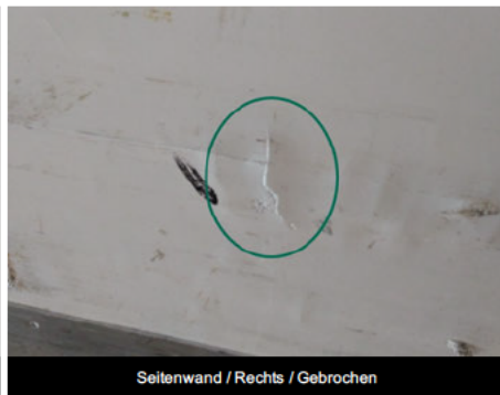
Seitenwand / Rechts / Gebrochen
