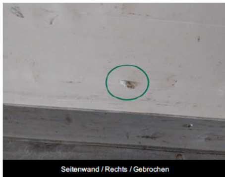
Seitenwand / Rechts / Gebrochen
