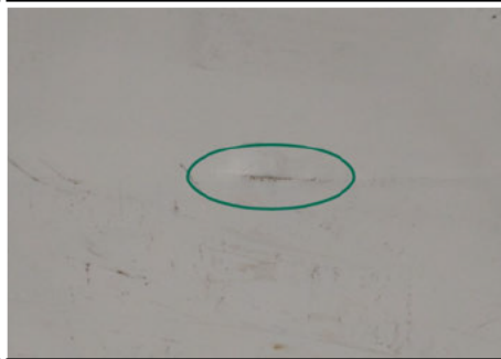
Dach / Hinten / Gebrochen
