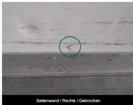
Seitenwand / Rechts / Gebrochen
