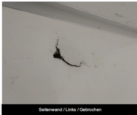
Seitenwand / Links / Gebrochen
