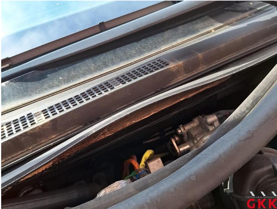
Bild 65. Windlauf, beschädigt, ersetzen
