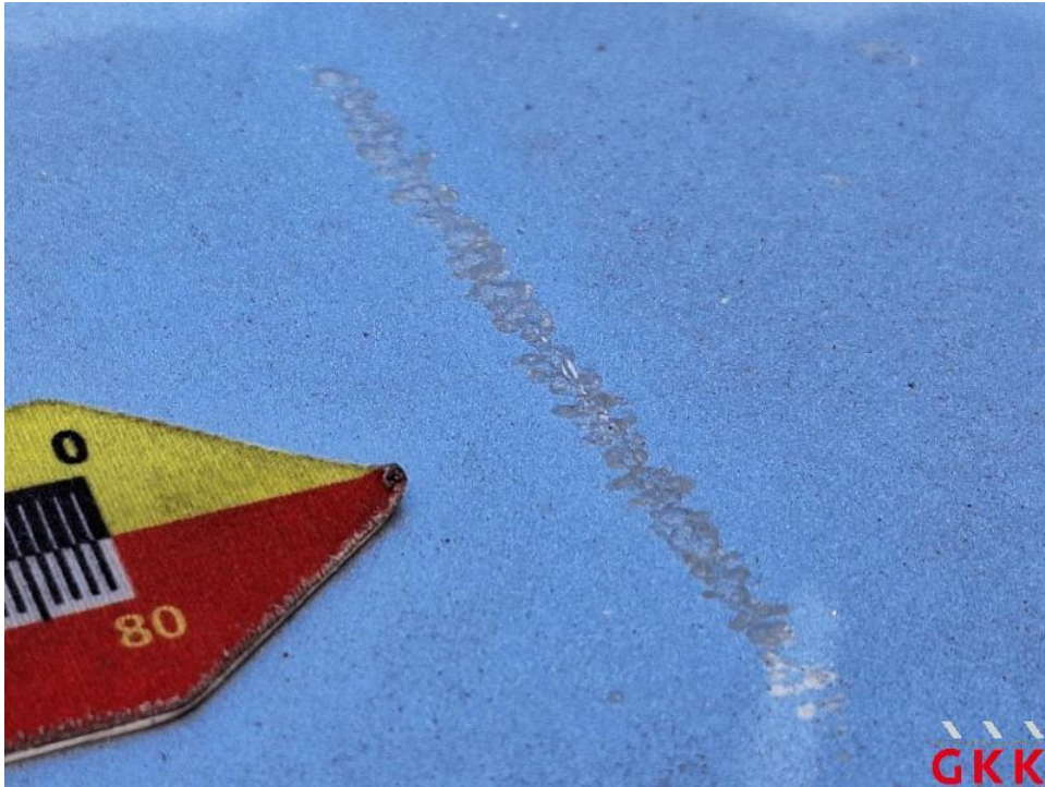
Bild 29. Dach, verkratzt, lackieren
