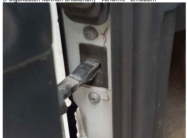
Beschädigung #14: Karosserie: A-Säule links (+ Einstieg) - gebrochen / gerissen - instandsetzen/lackieren (S3)
