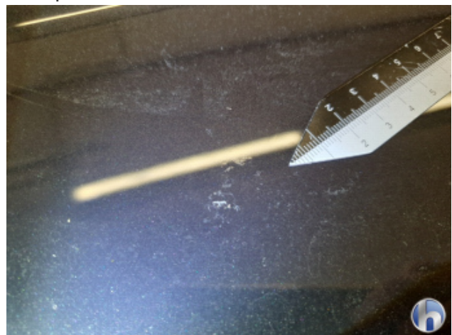
4. Dach Lackabplatzer - Lackieren
