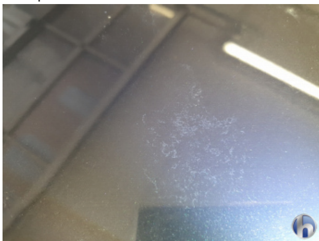
4. Dach Lackabplatzer - Lackieren
