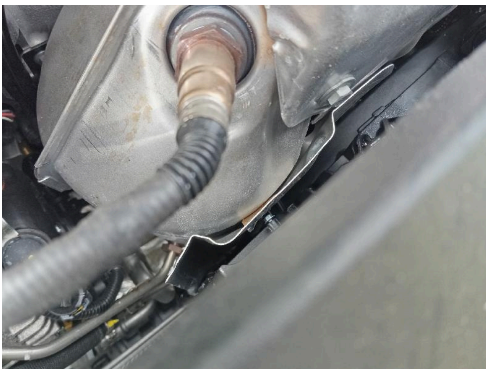
Bild: 54 Katalysator/Turbolader beaufschlagt deformiert
