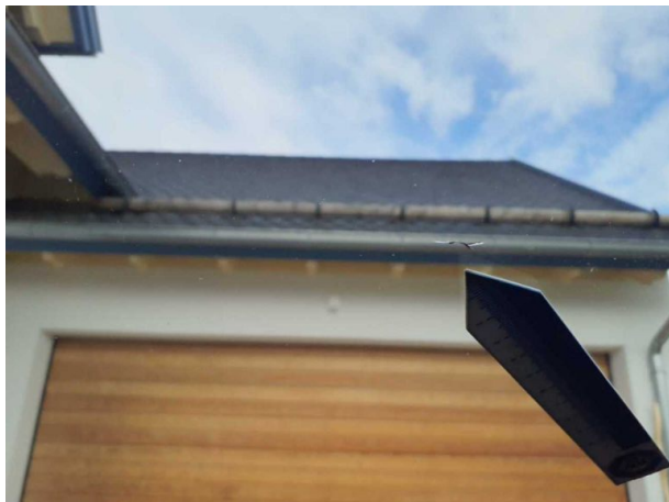
Beschädigung 8: Verglasung: Frontscheibe - gebrochen / gerissen - erneuern
