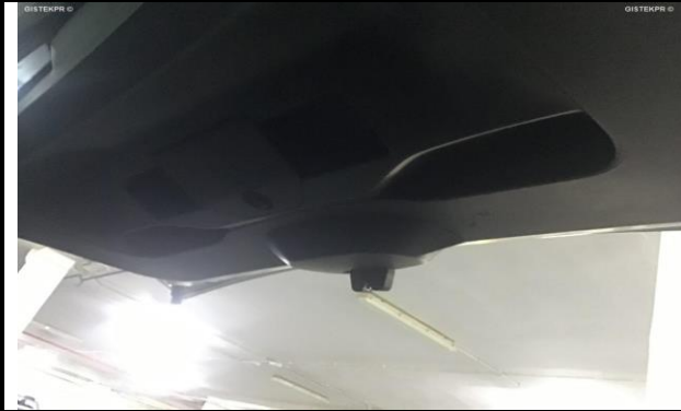
Foto daños internos 11
