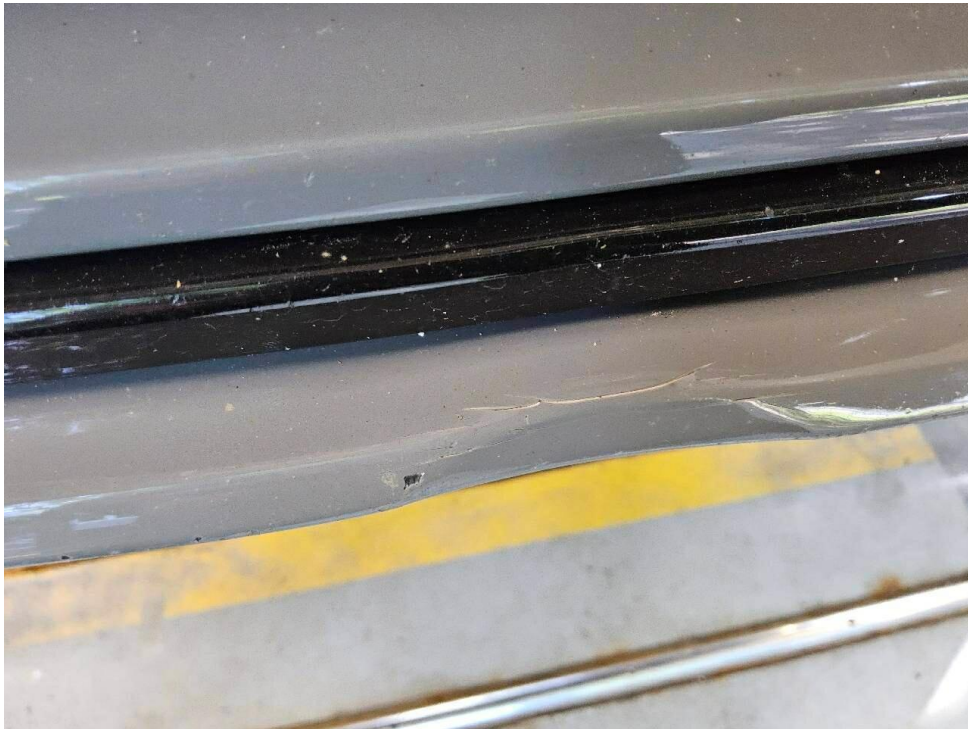
Bild 20 : Stoßfänger und Blende vorne rechts und gebrochen
