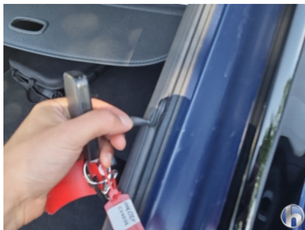
2. Heckklappendichtung Riss - Erneuern
