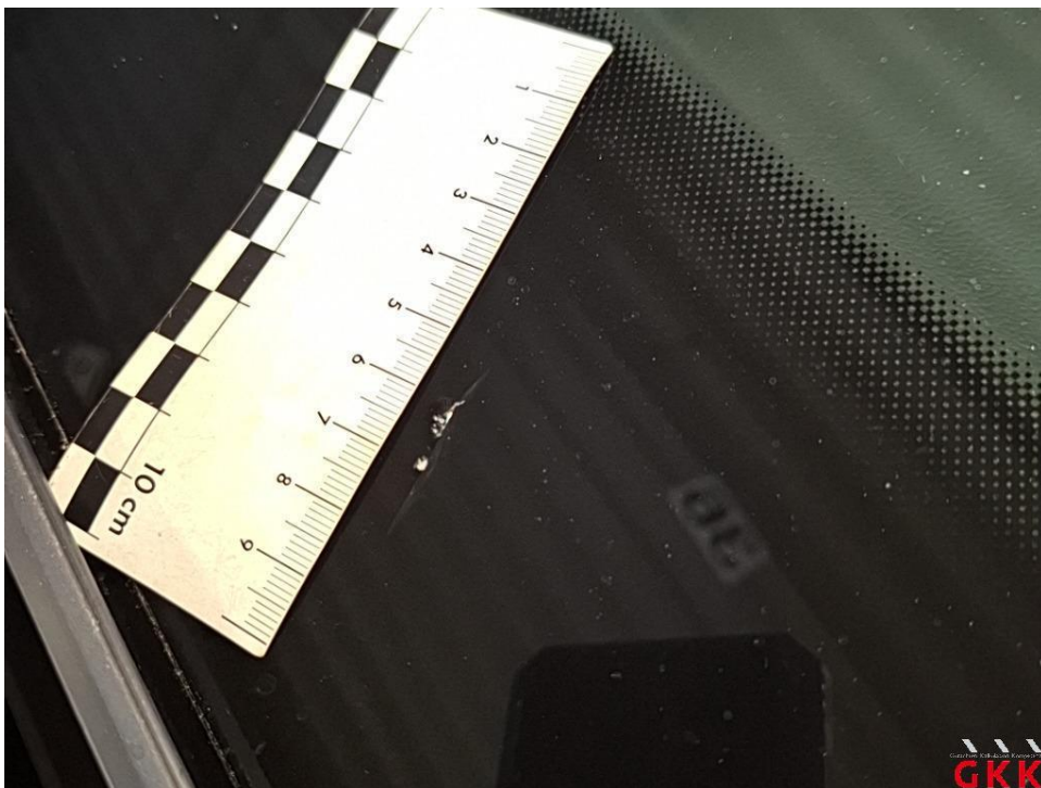
Bild 18 Frontscheibe, mit Regensensor und Frontkamera, gerissen, ersetzen
