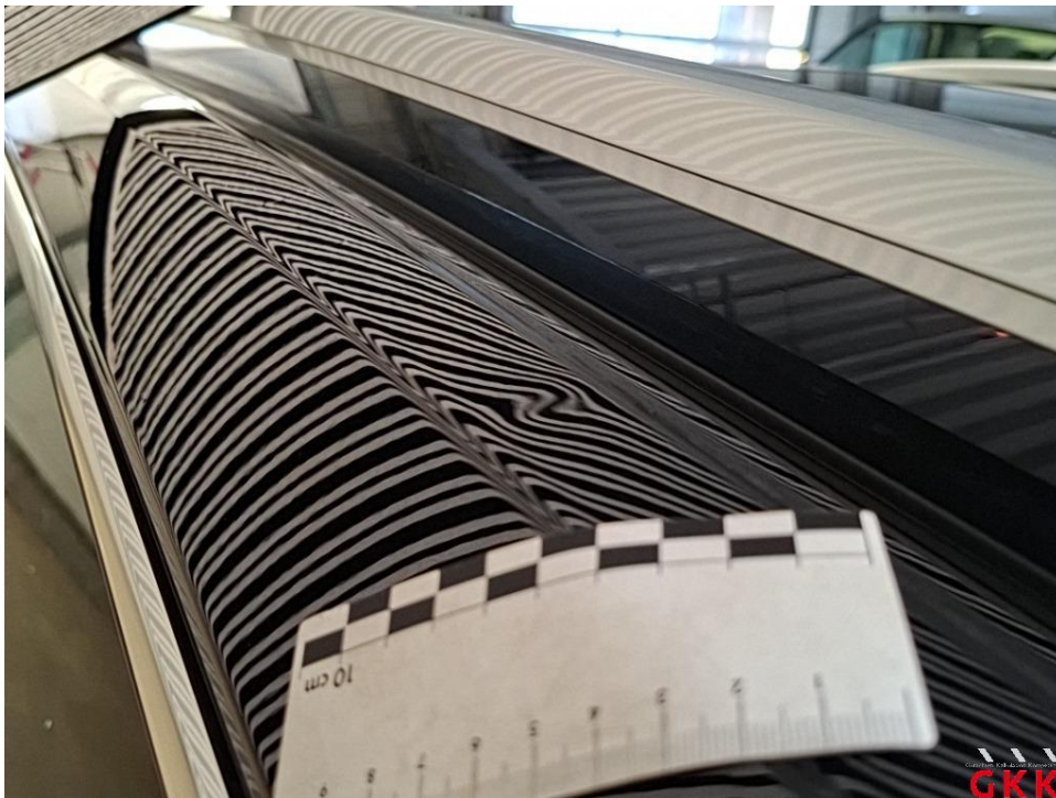
Bild 22 Dach, Holm links, beschädigt, instand setzen - lackieren
