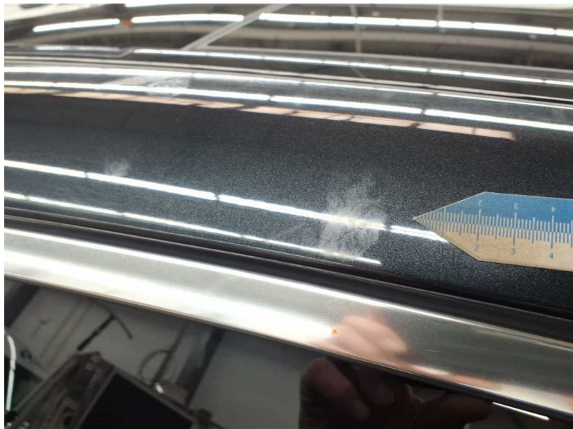
Beschädigung #14: Fahrzeugdach: Dachholm rechts (Einätzungen) - Lackmangel - lackieren
