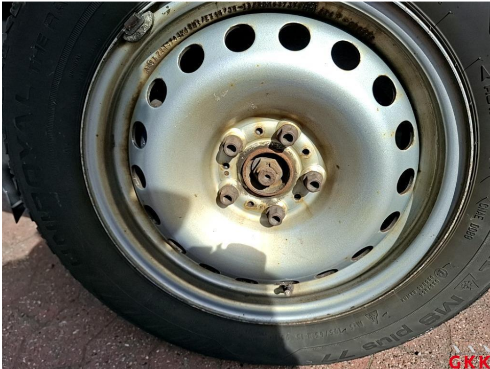
Bild 23. Nabenkappe, vorne links, fehlt, ersetzen
