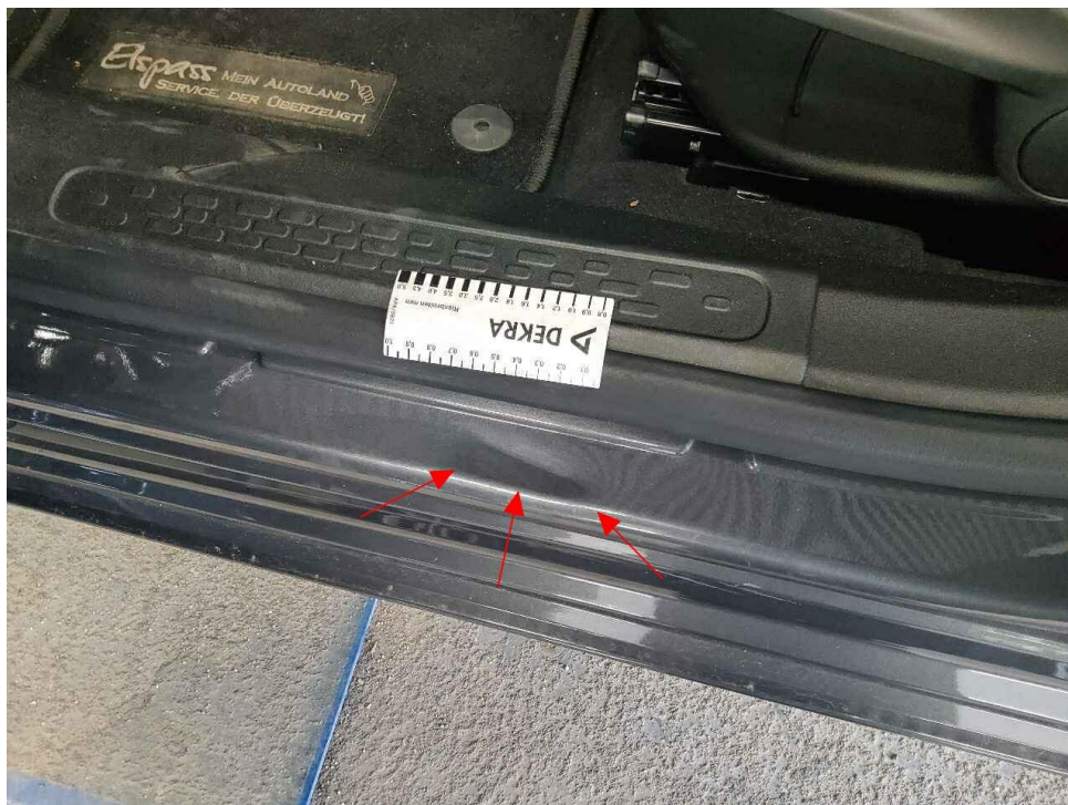
Bild 30 : Tür vorne links, Einstieg, eingedellt
