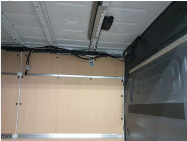
Beschädigung #2: elektrisches System: Kabelstrang - abweichend Auslieferungszustand - de-/montieren
