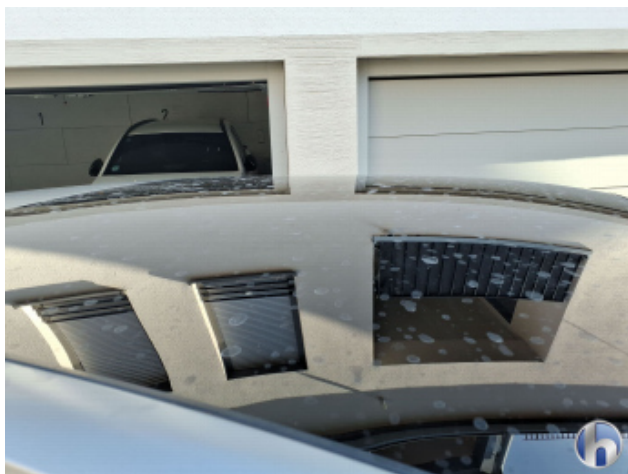
8. Dach Verschmutzt - Entkleben / Reinigen
