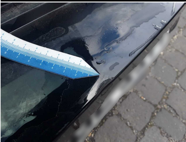
Beschädigung #4: Stossfänger hinten: Stossfänger hinten - verformt - erneuern
