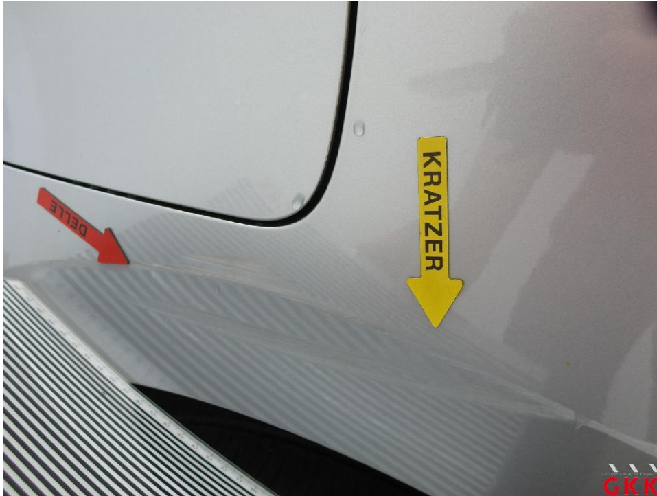
Bild 31. Seitenwand rechts, beschädigt, instand setzen - lackieren
