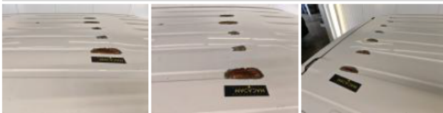
Dak, Roest / Corrosie, Herstellen en spuiten (compleet)
