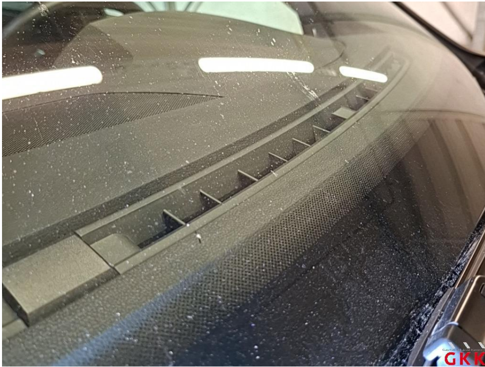
Bild 27 Frontscheibe, mit Regensensor und Frontkamera, Steinschlag mit Rissbildung, ersetzen
