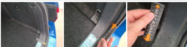
Joint de coffre, Déchirure, E - Remplacer
