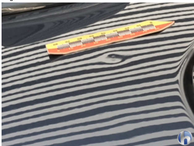
4. Dach Hagelschaden - Sanft Instandsetzen
