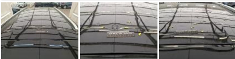
Pavillon, Grêlé, LI - Réparer et peindre (complet)
