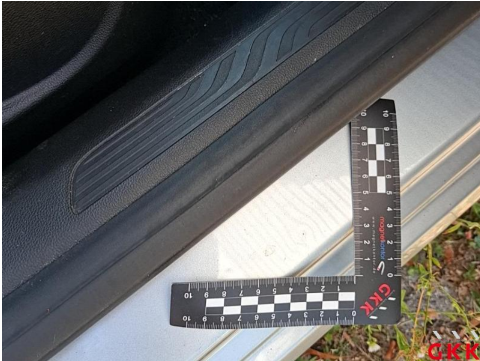
Bild 55. Tür vorne rechts, Einstieg, beschädigt, instand setzen - lackieren
