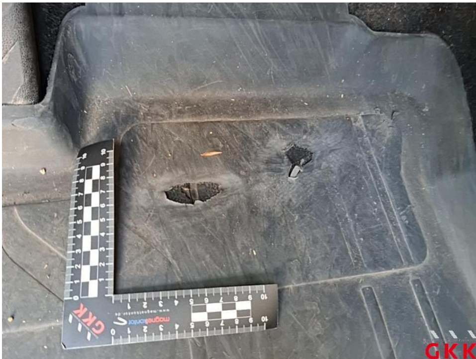
Bild 37. Fußmatte(n), vorne links, beschädigt, ersetzen
