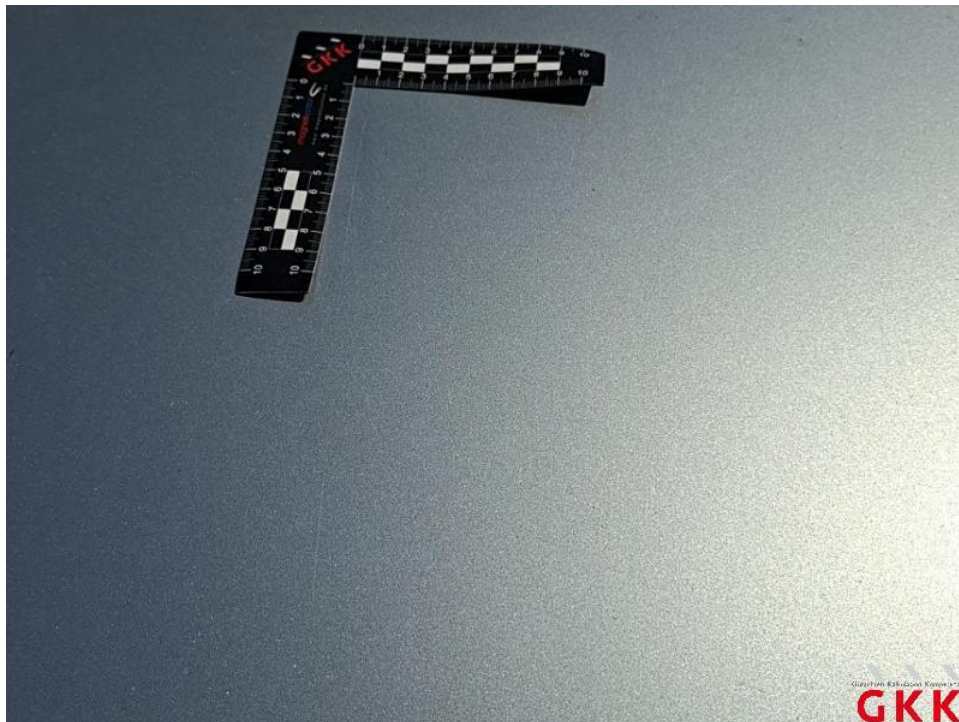
Bild 69. Dach, verkratzt, lackieren
