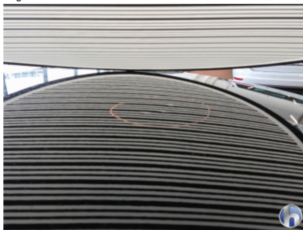
3. Dach Hagelschaden - Siehe Kalkulation
