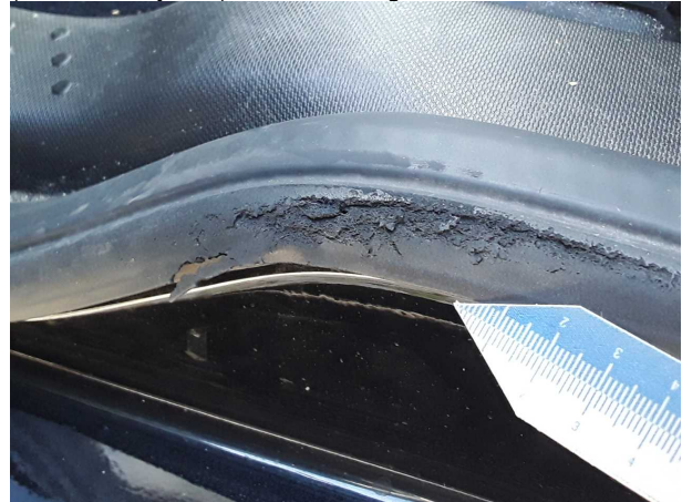
Beschädigung #2: Tür vorn links: Türdichtung - beschädigt - erneuern
