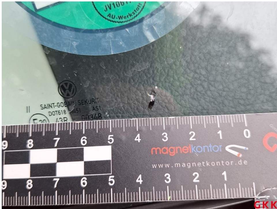
Bild 13. Frontscheibe, wärmedämmend, Steinschlag mit Rissbildung, ersetzen
