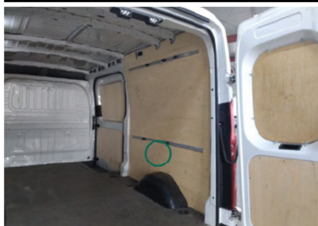
Innenverkleidung Laderaum / Rechts / Gebrochen
