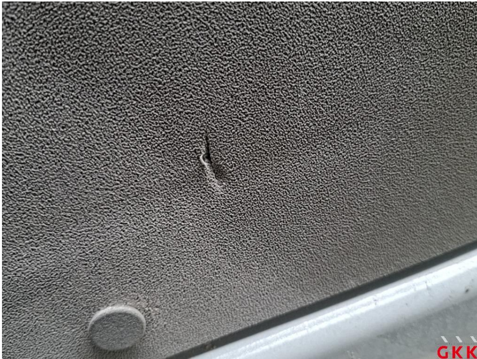
Bild 37 Schiebetür rechts, Innenverkleidung, beschädigt, ersetzen
