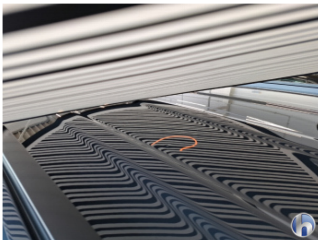
4. Dach 2 Dellen - Sanft Instandsetzen
