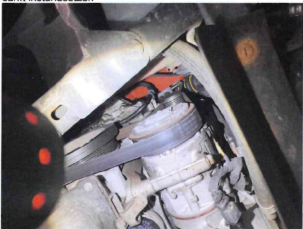
Beschädigung #12: Motor: Motor (Ölverlust, mehrkosten möglich) - undicht - befunden ggf. instandsetzen
