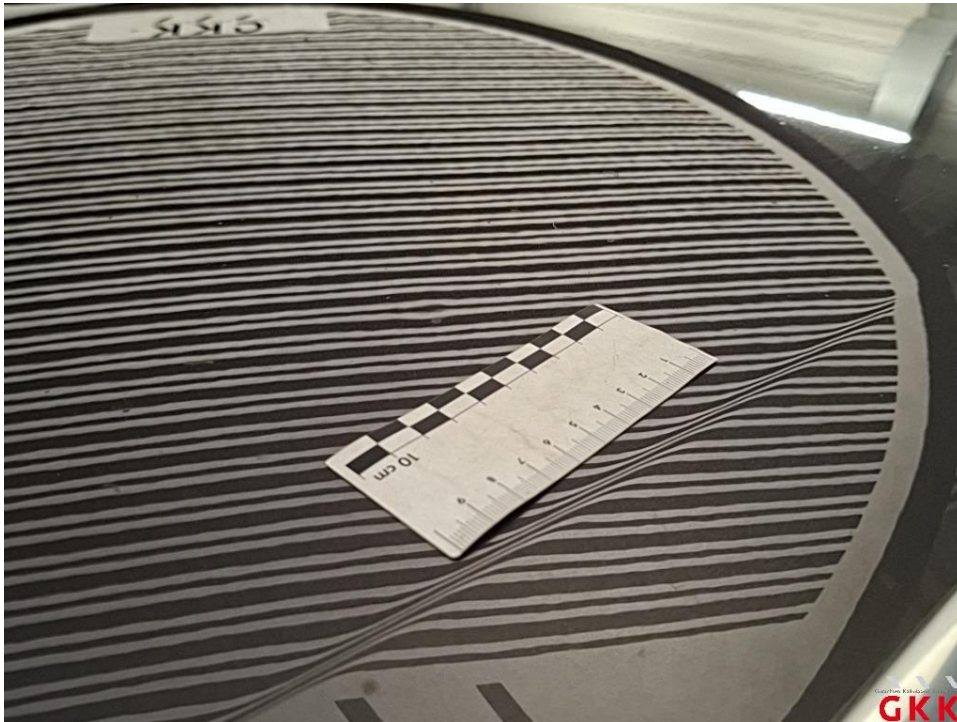
Bild 33 Dach, beschädigt, kalt drücken
