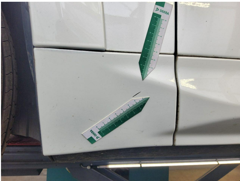
Bild 16 : Blende Kotflügel vorne links Kratzer
