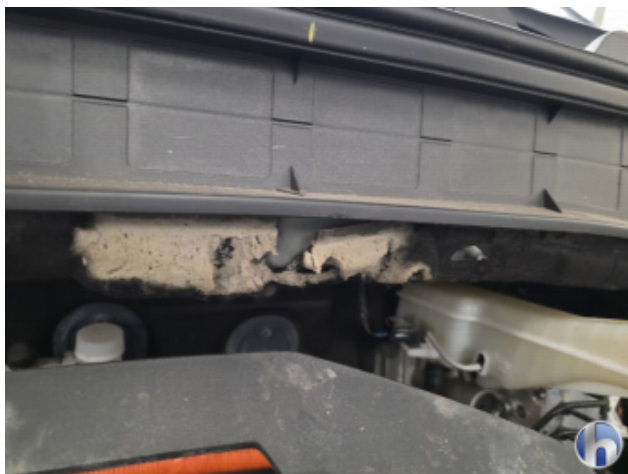
3. Motordämmmaterial Marderbiss /-schaden - Erneuern
