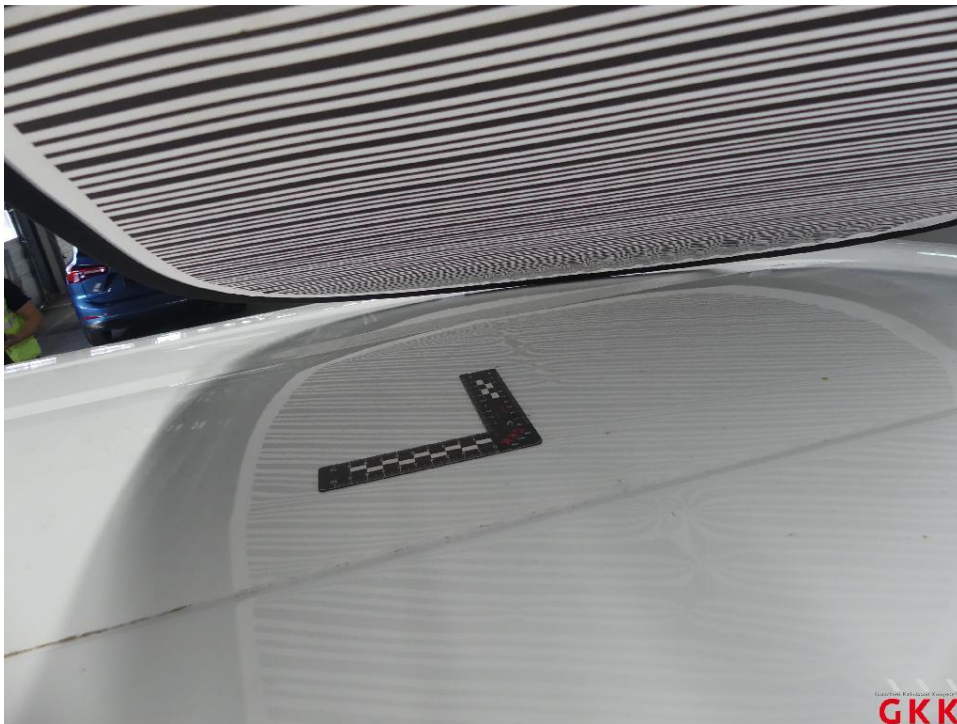
Bild 34 Dach, beschädigt, instand setzen - lackieren
