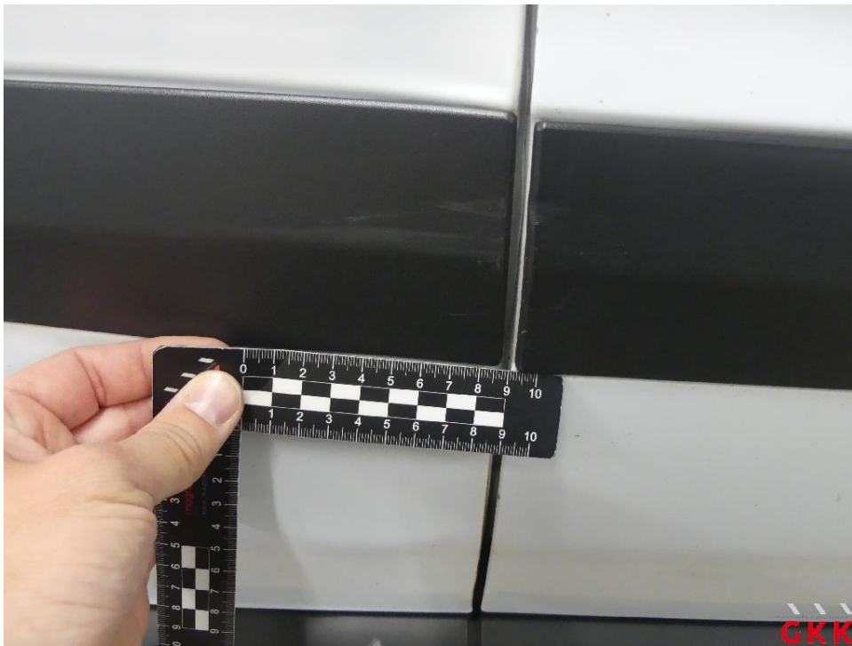
Bild 28 Tür hinten rechts, Leiste unten -unlackiert-, beschädigt, ersetzen
