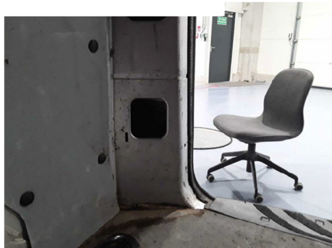
Beschädigung 17: Verkleidungen/Abdeckungen: D-Säule rechts Verkleidung innen - fehlt - erneuern
