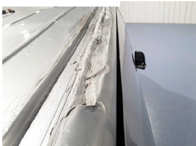
Beschädigung 36: Fahrzeugdach: Dachholm rechts - beschädigt - erneuern
