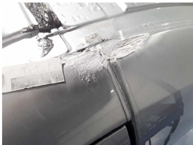
Beschädigung 37: Fahrzeugdach: Dachholm rechts - beschädigt - erneuern
