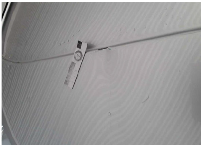
Beschädigung 10: Tür hinten links: Tür - beschädigt - erneuern
