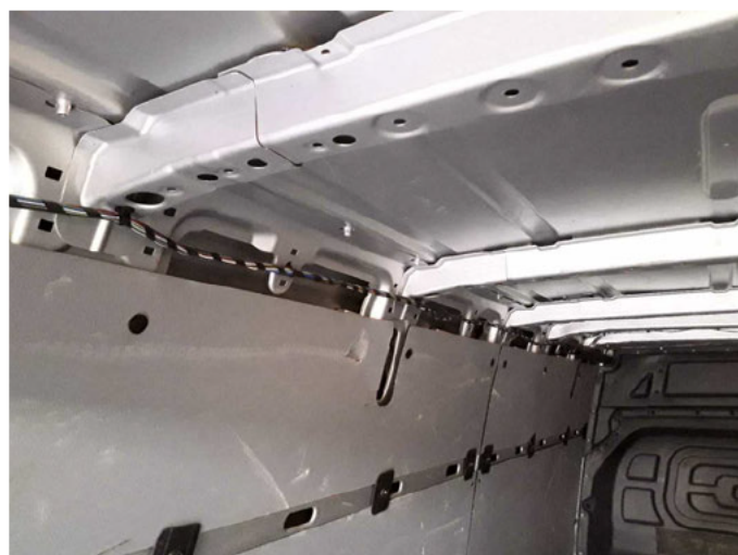
Beschädigung 16: Seitenwand links: Innenverkleidung - fehlt - erneuern
