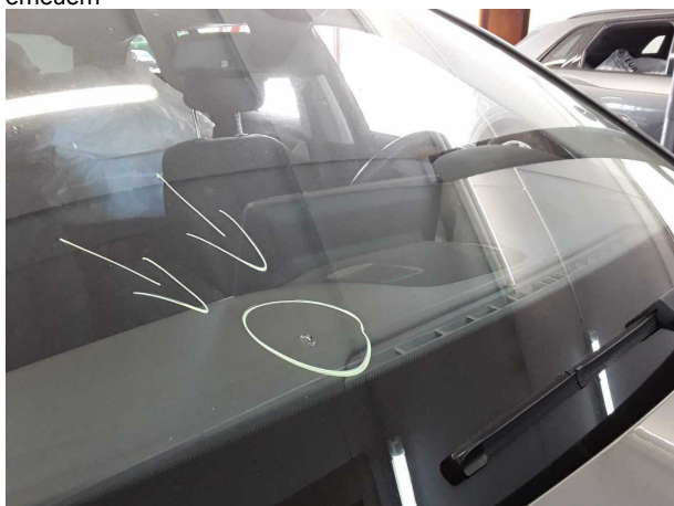
Beschädigung #4: Verglasung: Frontscheibe (Rissbildung) - Steinschlag - erneuern
