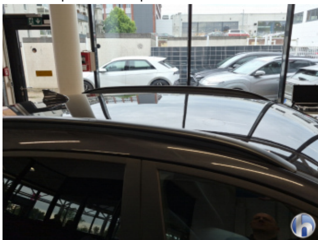
1. Dach Gebrauchsspuren - Ohne Reparatur
